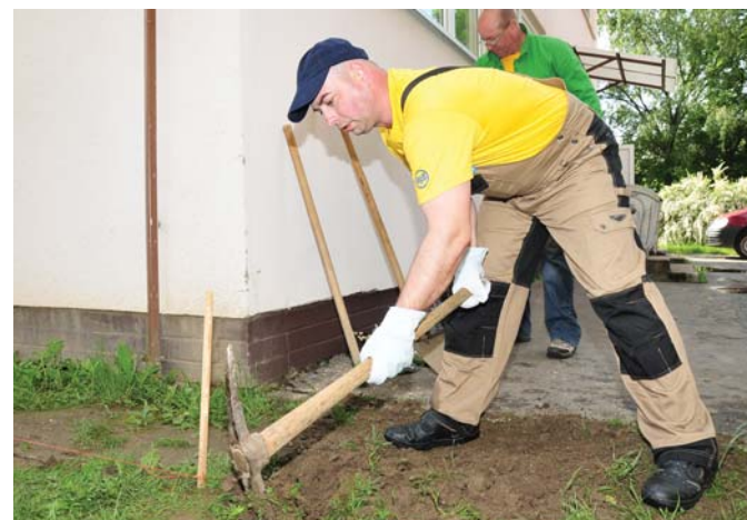
Stanislav Lucík z divízneho závodu Radiátory a rúry pri príprave terénu na uloženie dlažby.
