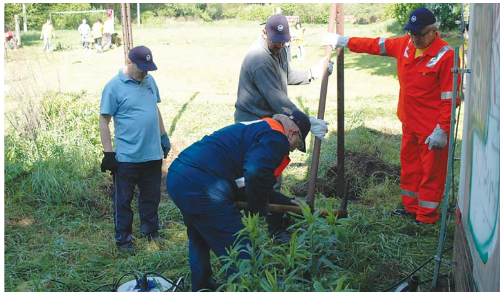
Skupina odborárov sa pustila do likvidácie nepotrebných oceľových konštrukcií.
