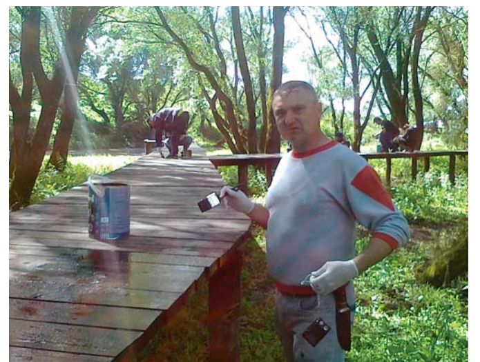
Štefan Karajoš z DZ Radiátory a rúry odviezol kus roboty.
