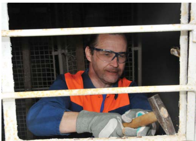
Pavla Babeja, jedného z členov partie z divízneho závodu Mechanika, sme zastihli pri vysekávaní popraskaného skla z pivničných okien.
