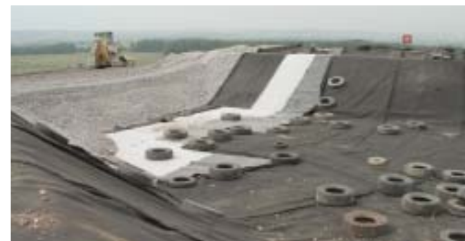
Príprava skládky nebezpečného odpadu Preparation of Hazardous Waste Landfill
