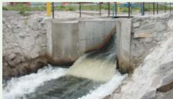
Výpusť do Sokolánskeho potoka Water discharged to Sokolany stream
